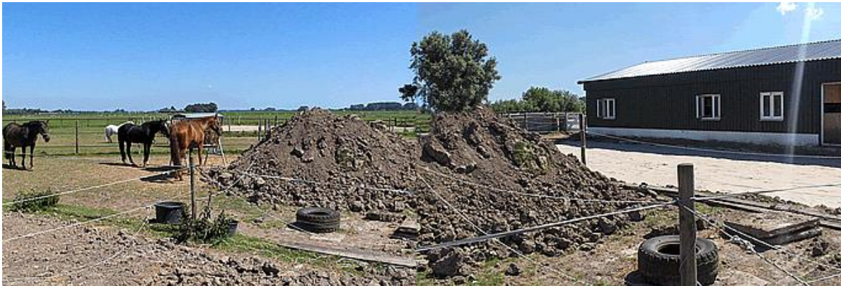
De aanleg van de paddock. Met veel houtje-touwtje werk om de paarden toch elke dag naar buiten te kunnen laten gaan en één (het waren er drie...) van de bergen uitgegraven kleigrond.
